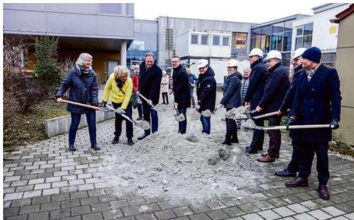
Die Berufliche Schule erhält einen Erweiterungsbau: Am Mittwoch war Spatenstich, unter anderem Landrat Joachim Walter, Oberbürgermeister Stephan Neher, Schulleiter Stefan Neu und die Architekten Jan Kliebe und Sandro Rendina schnappten sich die Spaten.
